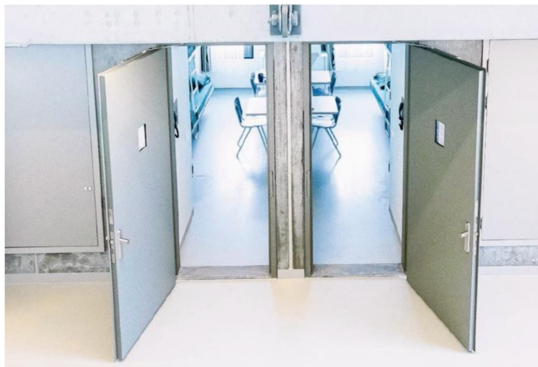
Het Justitieel Complex Zaanstad, met duizend 'justitiabelen' de grootste en meest innovatieve gevangenis van Nederland.
